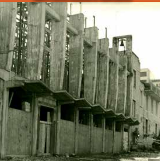
1960 Il nuovo oratorio in costruzione
