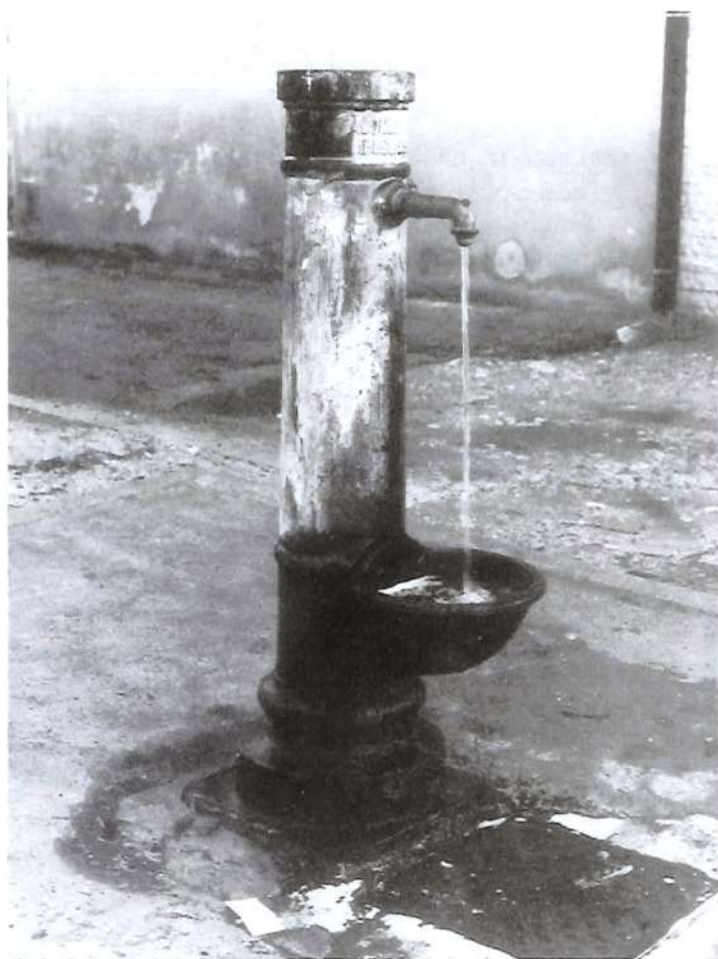
La fontana di Via Duca d'Abruzzo a Terlizzi. Perde un litro e mezzo di acqua potabile ogni quindici secondi, circa quattrocentomila litri di acqua in due mesi.
