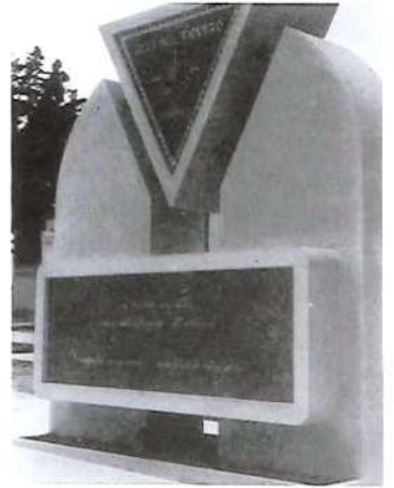
Il monumento, che accoglie le spoglie di don Ambrogio, sobrio nella sua eleganza è allestito dalla Ditta Mauro De Gennaro di Molfetta, su progetto del geometra Michele De Gennaro. Il mosaico è della Ditta Signorini di Ravenna.
