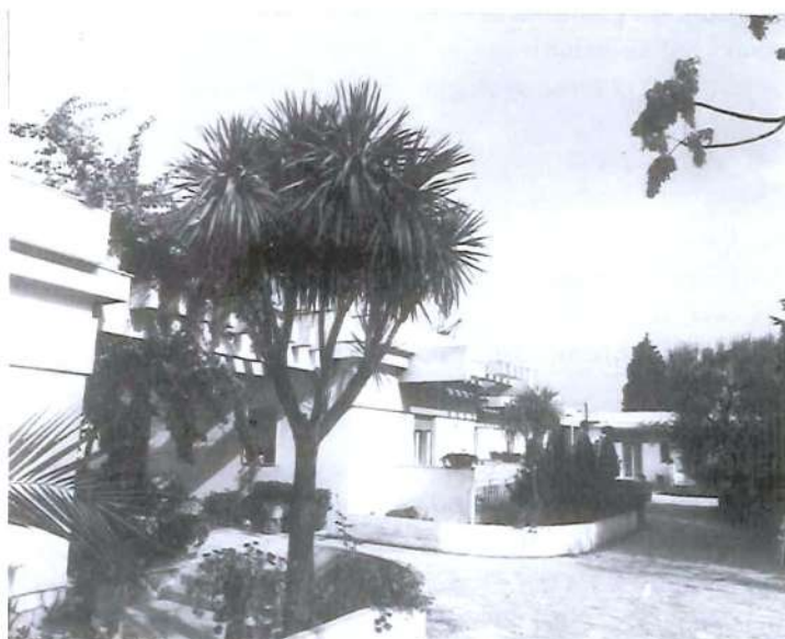
Fra le Case dell'Opera, la sede di Terlizzi, aperta nel 1964 e di recente ampiamente ristrutturata, è luogo di ospitalità per anziani e sede di no-viziato.
