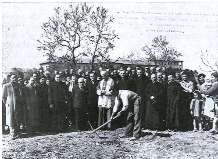
2 aprile 1949: il primo simbolico colpo di piccone ad inizio dei lavori dell'Opera.
