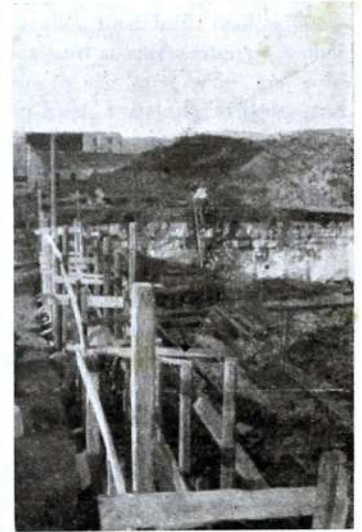
Emergono i primi pilastri della Casa della Buona Novella
